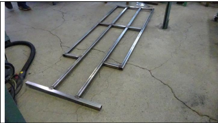
完成したフレーム
