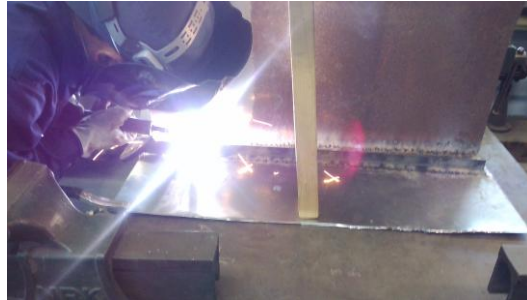
アーク溶接で 土台を接合させている様子
